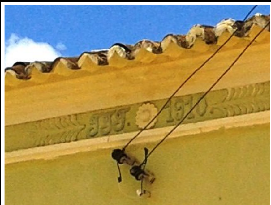
Fachada da casa de Trasíbulo.
